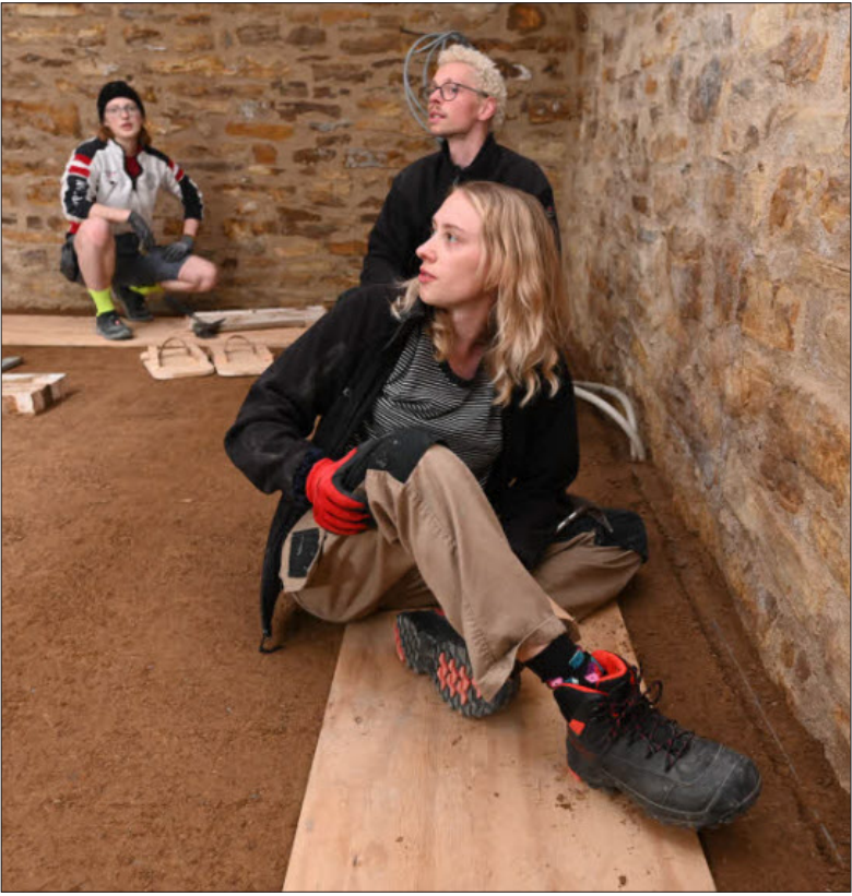
Studenten der Stuttgarter Hochschule für Technik arbeiten am Stampflehm Boden in der Oberamteistraße 34.
