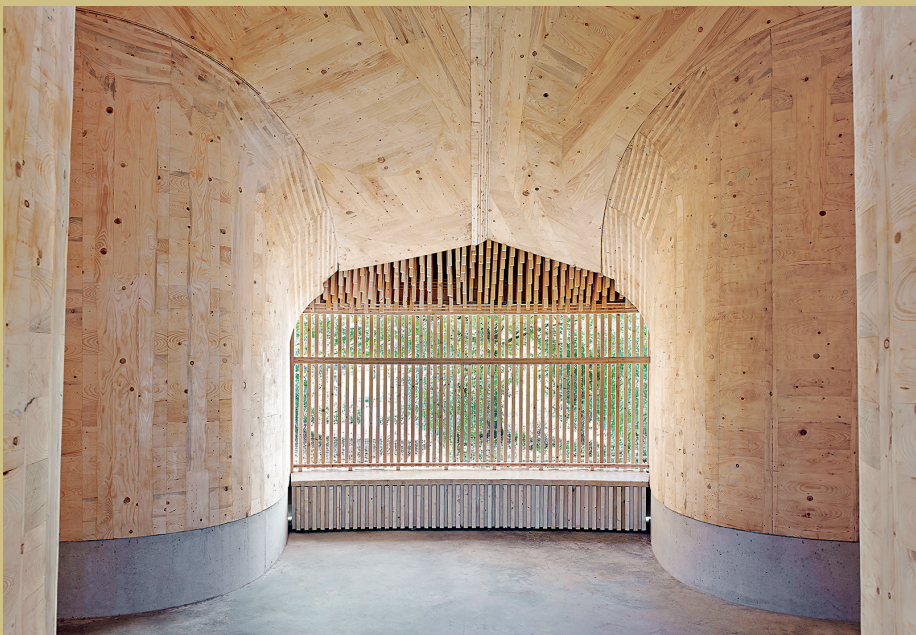
Innenraum, Jugendtreff Ingersheim: Die massiven Holz-Schalungselemente erhalten durch ihre Geometrie und Komposition eine textile Anmutung. Foto: Achim Birnbaum
